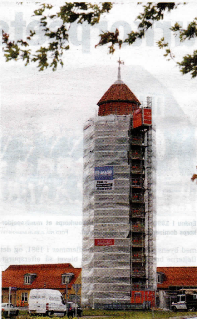
Vandtårnet er i øjeblikket pakket ind fra top til tå, mens den omfattende udendørs renovering står på. ARKIVFOTO: CLAUD HANSEN
