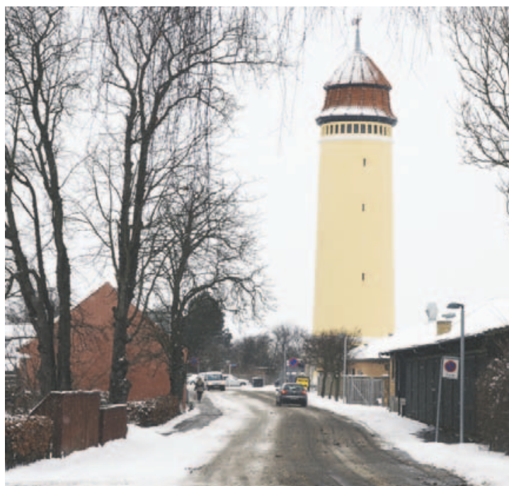
Det aldrende vandtårn har for nylig gennemgået en omfattende renovering, hvor tårnet også blev malet. ARKIVFOTO: ANDERS KNUDSEN
